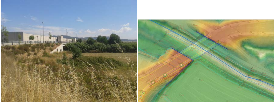
Vista i planta de l'obra d'accés a les instal·lacions del Grupo Inditex al marge esquerre de la riera de Vallmanya.
