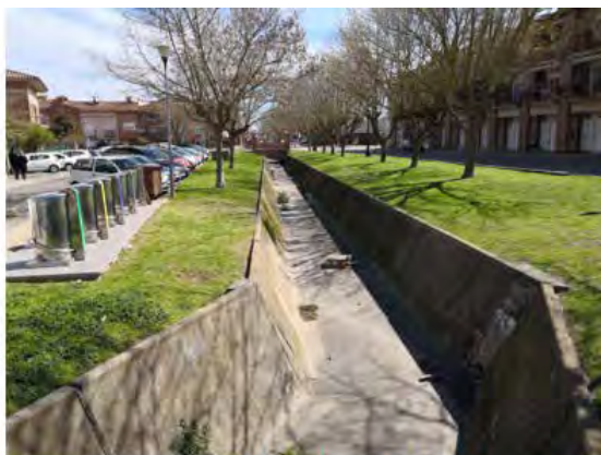
SORTIDA DE LA RIERA A L'OBRA DE DRENATGE
