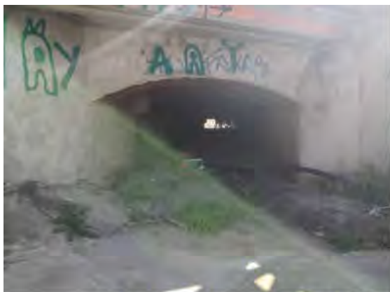
ENTRADA DE LA RIERA A L'OBRA DE DRENATGE
