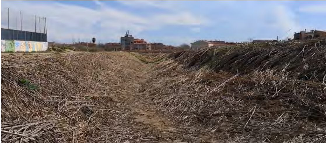
Vista de la llera del Torrent d'en Burgada.
