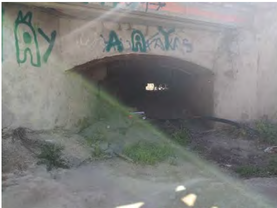
ENTRADA A L'OBRA DE DRENATGE PREVI AL CREUAMENT AMB EL PASSEIG DEL MESTRE PAU CASALS
