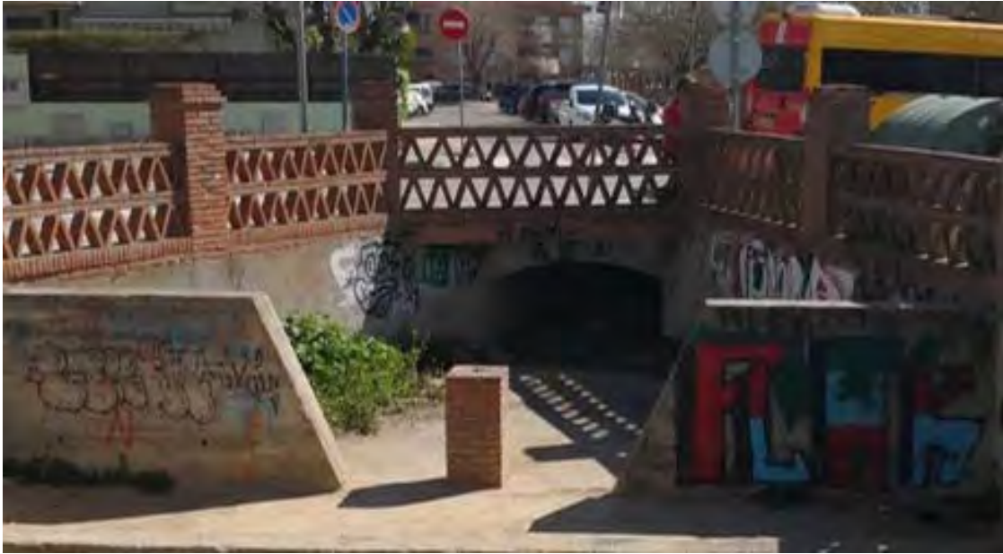
Obra de drenatge de la riera d'en Burgada en el creuament amb el Passeig del Mestre Pau Casals
