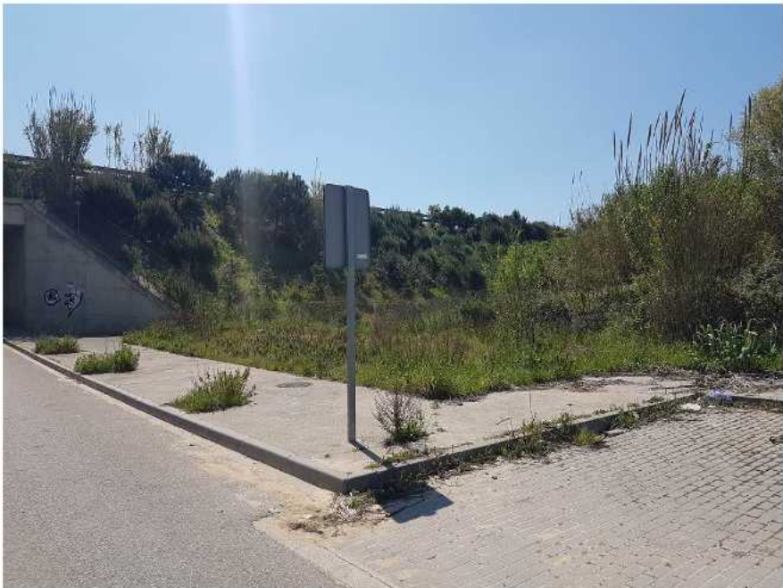
Vista de la parcel·la on s'evoquen les aigües provinents de les obres de drenatge de l'autopista C-32
