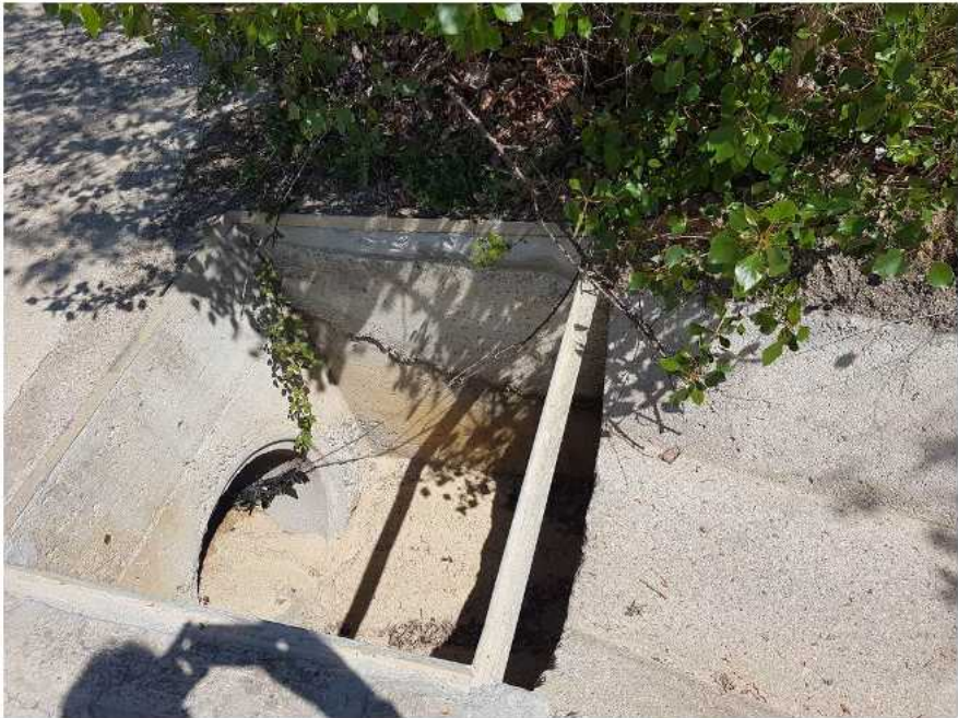
Canalització mitjançant tub de formigó de les aigües pluvials provinents de la cuneta
