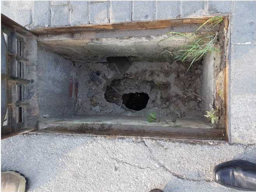
Detall de l'interior de embornal que connecta al pou de l'arqueta del rec viver
