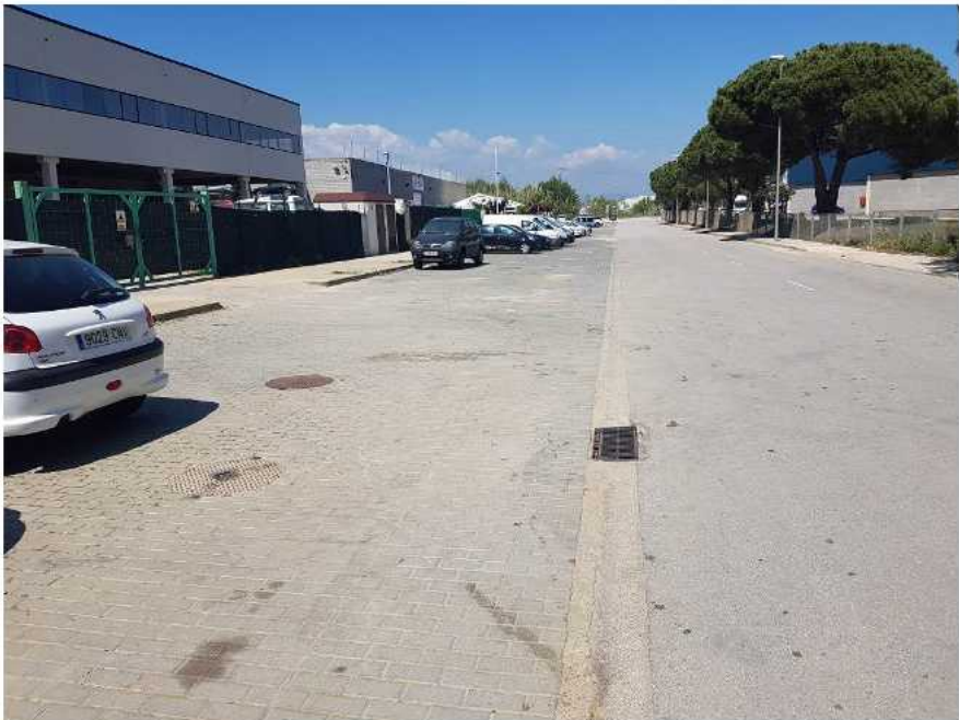
Detall de la xarxa de clavegueram a la part esquerre del carrer, els dos pous de registre (pluvial i residual) i un embornal.
