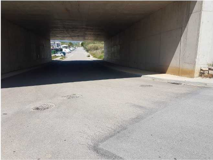
Detalls dels pous de clavegueram a la part superior del carrer.
