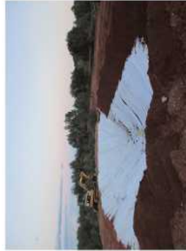
Impermeabilització amb una sola peça de EPDM soldada a fabrica
