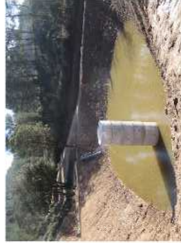
Peces de formigó prefabricat muntades sobre solera (ja submergida)
