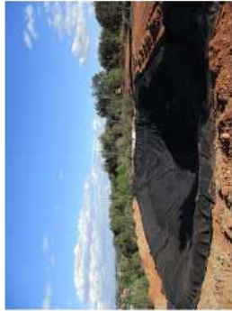
Impermeabilització amb una sola peça de EPDM soldada a fabrica
