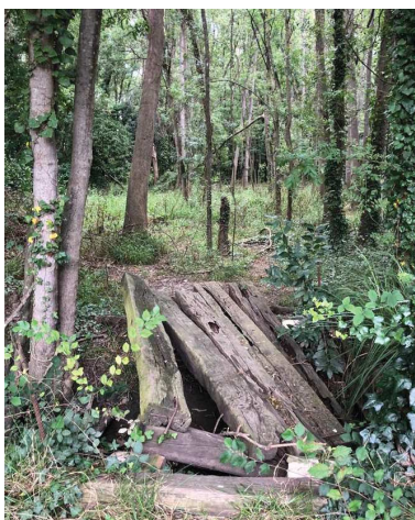
Figura 51. Pont del Gorg
