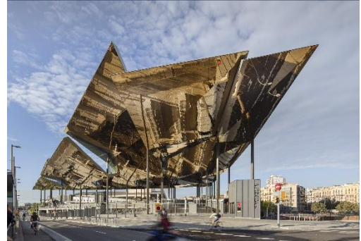
Coberta fotovoltaica de Els Encants. Font: Rafael Vargas.
