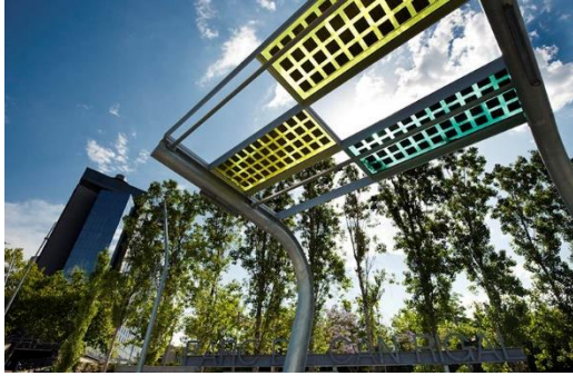
Instal·lació fotovoltaica al Parc de Can Rigalt. Font: Josep Cano.
