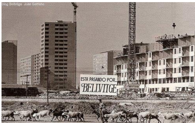
Construcció de blocs de pisos a Bellvitge, 1970. Font: José Serrano, Blog Bellvitge.
