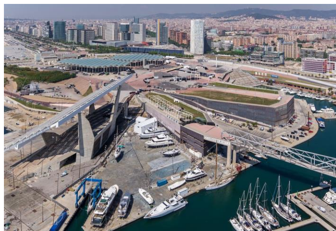
Vista aèria de la plaça del Fòrum. Font: Imatges Barcelona, www.barcelona.cat
