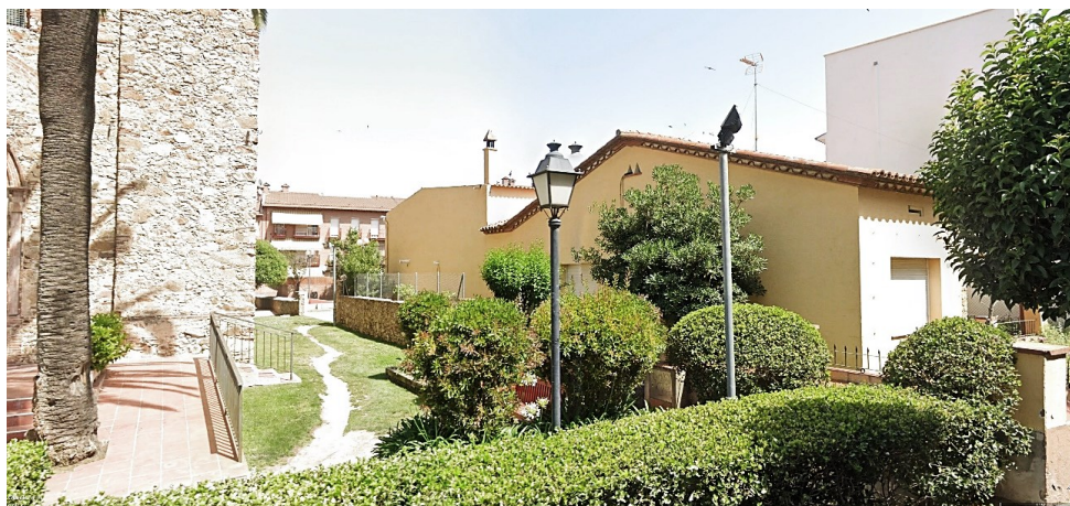
Franja lliure d'edificació del costat sud de l'església
