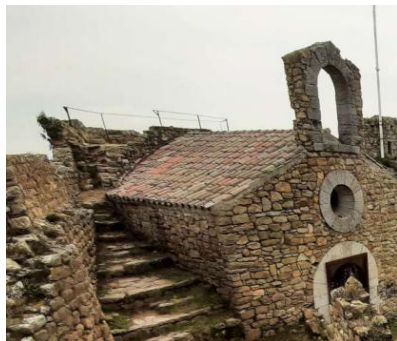
Figs. 15 i 16.- Imatges en la qual s'aprecia l'impacte de les baranes i les seves escasses condicions de protecció enfront de caigudes.
