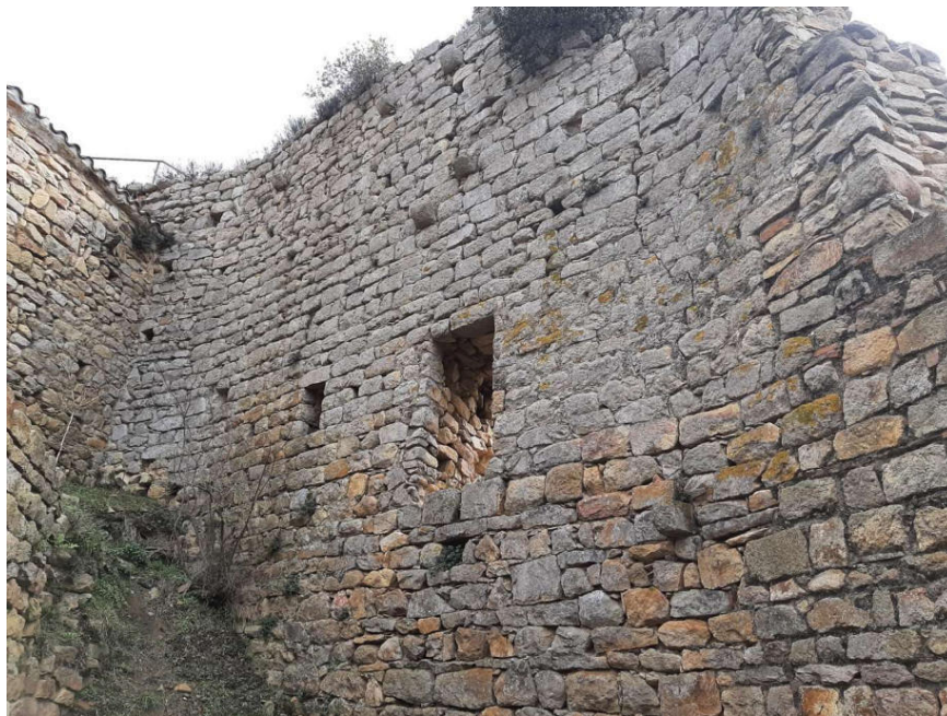
12. Mur sud de l'àrea 1 del recinte sobirà amb diverses esquerdes verticals en la fàbrica de carreus.
