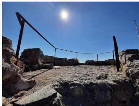
Figs. 15 i 16.- Imatges en la qual s'aprecia l'impacte de les baranes i les seves escasses condicions de protecció enfront de caigudes.
