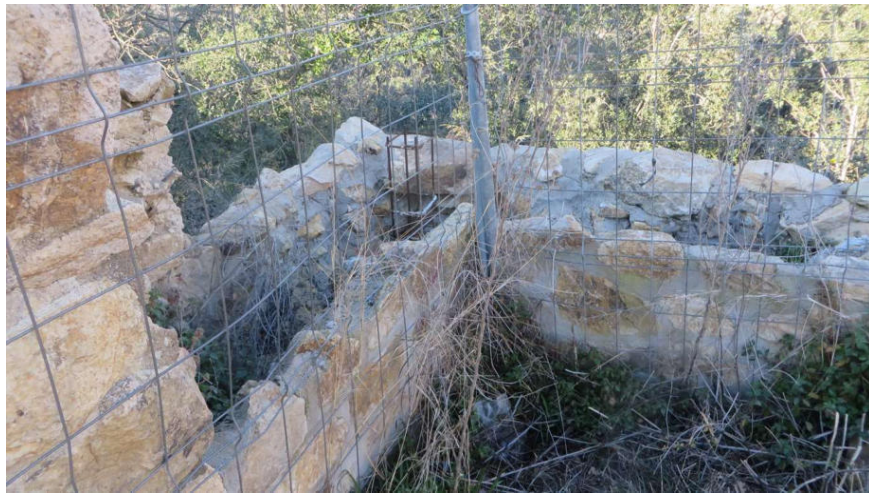
21. Reparació amb formigó armat entre murs de maçoneria de la cantonada nord-oest.
