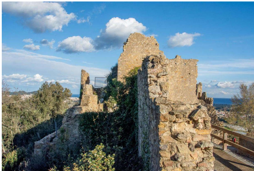
Fig. 4.- Imatge de l'interior del RJa7 on s'aprecia la proliferació de vegetació en extensió sobre els llenços que contribueix a la seva deterioració facilitant l'entrada d'aigua a l'interior de les fàbriques.
