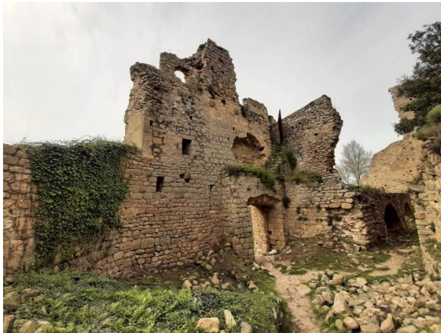
Fig. 3.- Imatge de l'interior del RSa1 on s'aprecia la proliferació de vegetació en extensió o de manera puntual sobre els llenços que contribueix a la seva deterioració facilitant l'entrada d'aigua a l'interior de les fàbriques.
