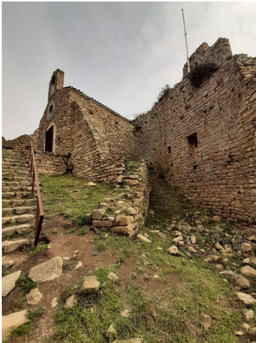
11- Trobada del mur sud amb la capella sobre el que es localitza el mirador cap el paisatge.
