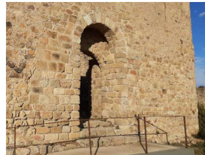
Figs. 11 i 12. Imatge de l'alçat exterior del llenç sud-oest del RSa1 en el qual es pot apreciar l'estat previ i posterior a la intervenció de restauració del buit d'accés principal al recinte Sobirà.
