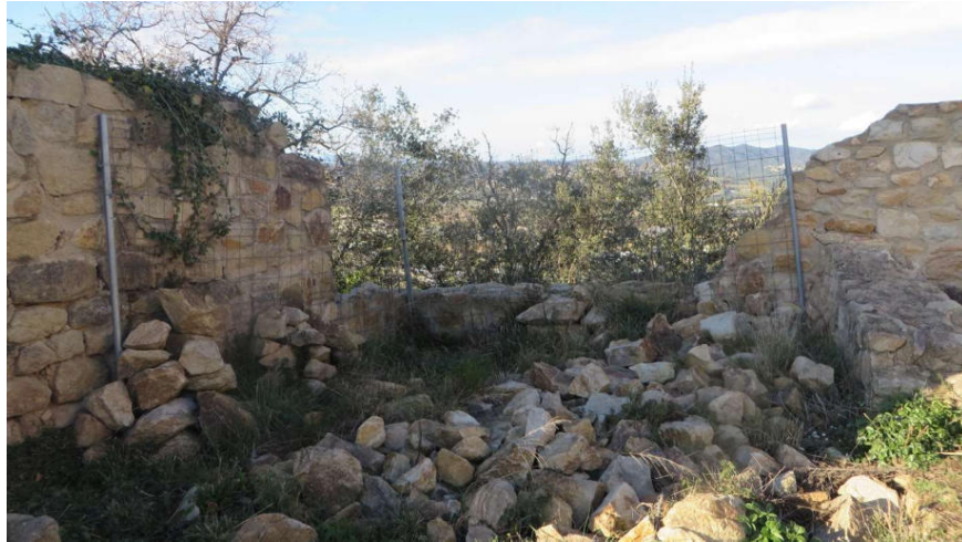
20. Tancament provisional i acumulació de pedres utilitzades en la reparació de murs en 1993.
