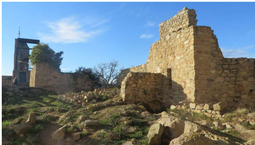
18. Vista des de l'est dels murs de tancament e interiors de l'àrea 7.
