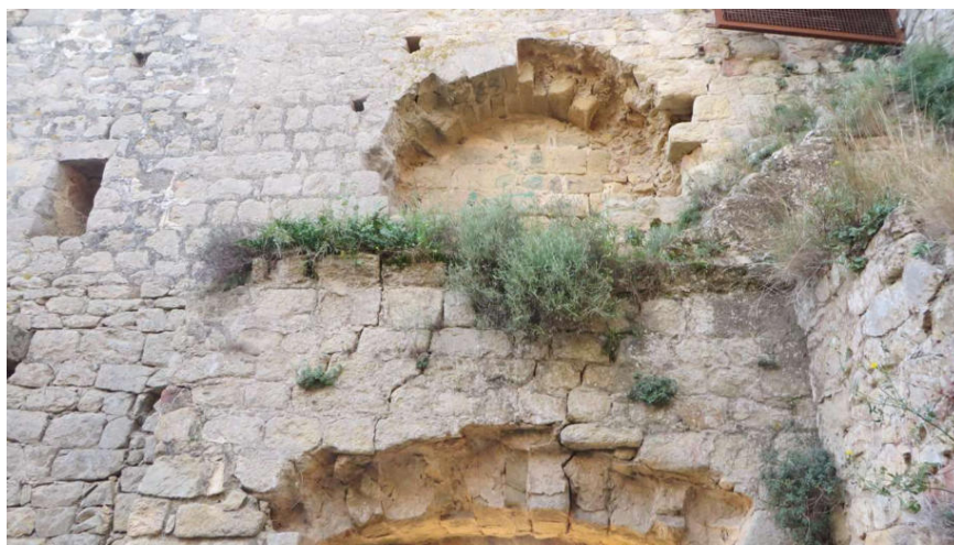
13. Danys en mur que conté la porta d'accés al recinte sobirà. Esquerres a la zona de l'arc de la porta.
