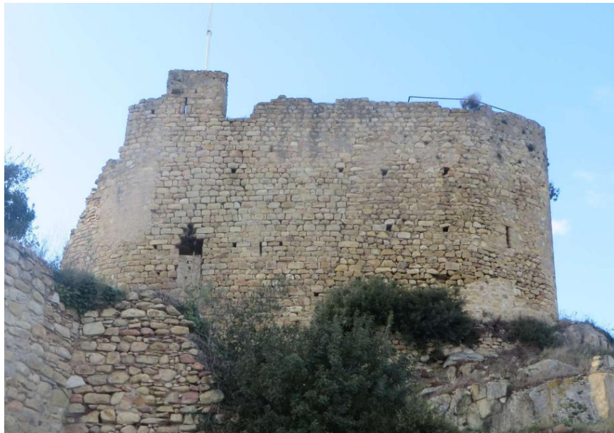
Fig. 17.- Imatge actual des de l'exterior del llenç sud-est amb la presència de la barana de protecció al nivell superior del mur.
