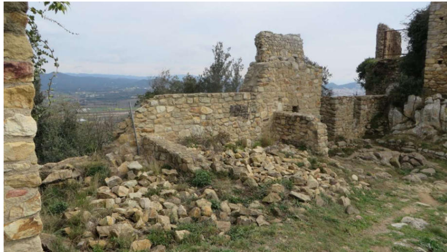
Fig. 2.- Imatge de l'interior de l'àrea RJa7 del recinte Jussà en la qual es pot apreciar el volum d'enderrocs apilats a l'interior dels murs.
