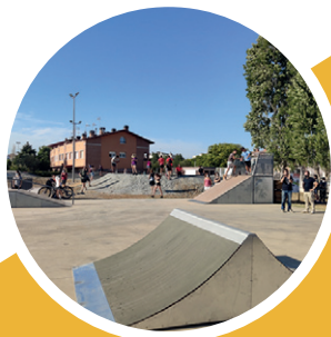
Actuació i millora de les instal·lacions de l'"skatepark"
